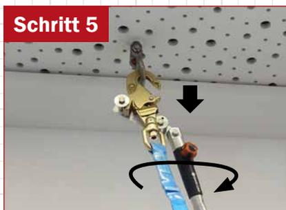
Stab nach unten ziehen und gegen den Uhrzeigersinn drehen. Dabei das Verbindungsmittel gegenhalten.
